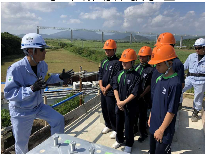
新空港道路 建設現場にて
